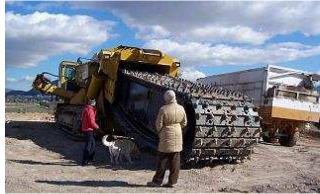
La zanjadora cuadruplica el trabajo que normalmente realiza una máquina IHERMAS
