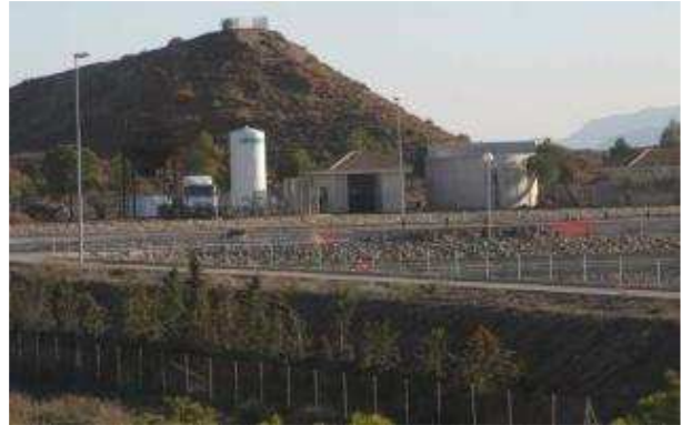
Imagen de la depuradora de Villena, de donde saldrá el caudal para riegos. información
