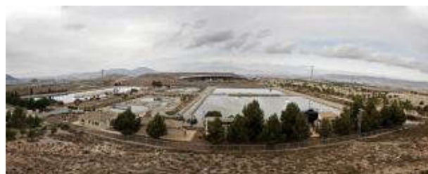
La depuradora de Villena recibe un caudal diario de 7.252 metros cúbicos procedentes de la localidad y de los municipios de Beneixama, Cañada y Campo de Mirra. CARLOS RODRÍGUEZ
