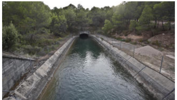
Canal de distribución del agua que llegará a Alicante del Tajo.
