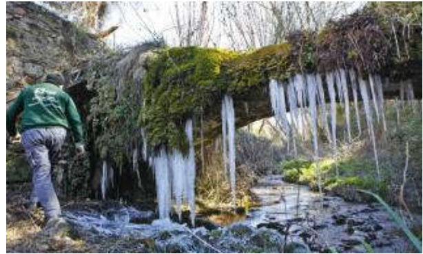
Imagen de los carámbanos que se habían formado ayer en una acequia de la cabecera del río Vinalopó, a la altura de Banyeres JUANI RUZ
