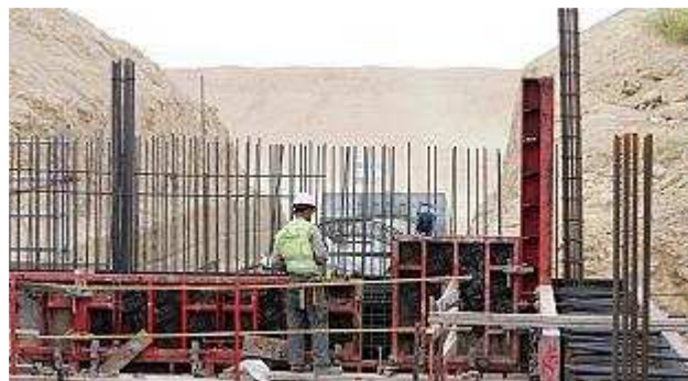
Un obrero trabaja en una de las infraestructuras del trasvase Júcar-Vinalopó en imagen de archivo. diego fotógrafo
