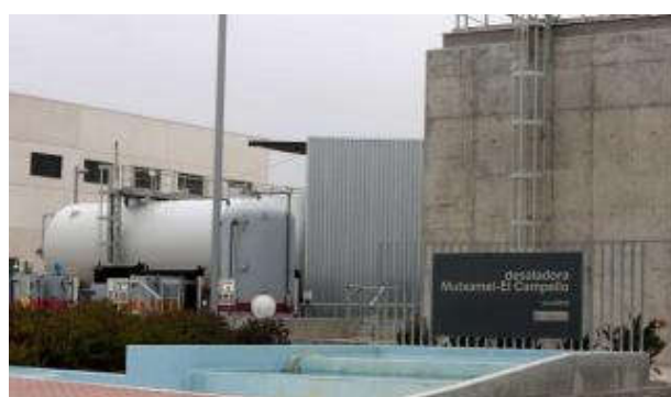
La desaladora de Mutxamel sólo se ha activado una vez desde que se construyera para dar agua a Benidorm. INFORMACIÓN
