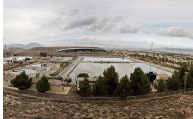
La Generalitat invertirá más de un millón de euros en adecuar la depuradora de Villena
