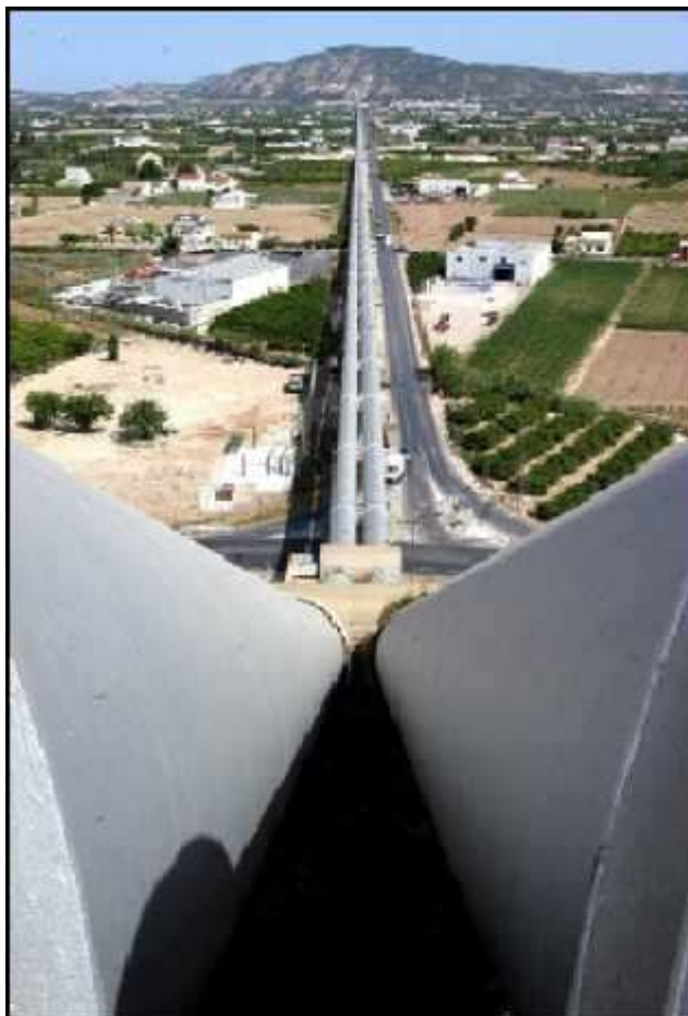
Vista general de la infraestructura del Tajo-Segura en la Vega Baja A. I.
