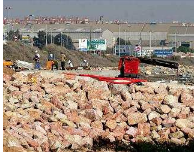
Imagen de archivo de las obras de ampliación de la desaladora de Agua Amarga en la primera línea del mar RAFA ARJONES
