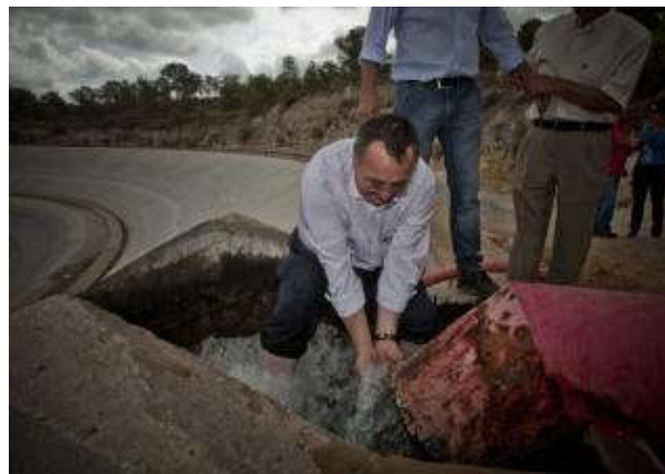
Estado actual que presenta la balsa reguladora de La Cuesta de Villena. CARLOS RODRÍGUEZ
