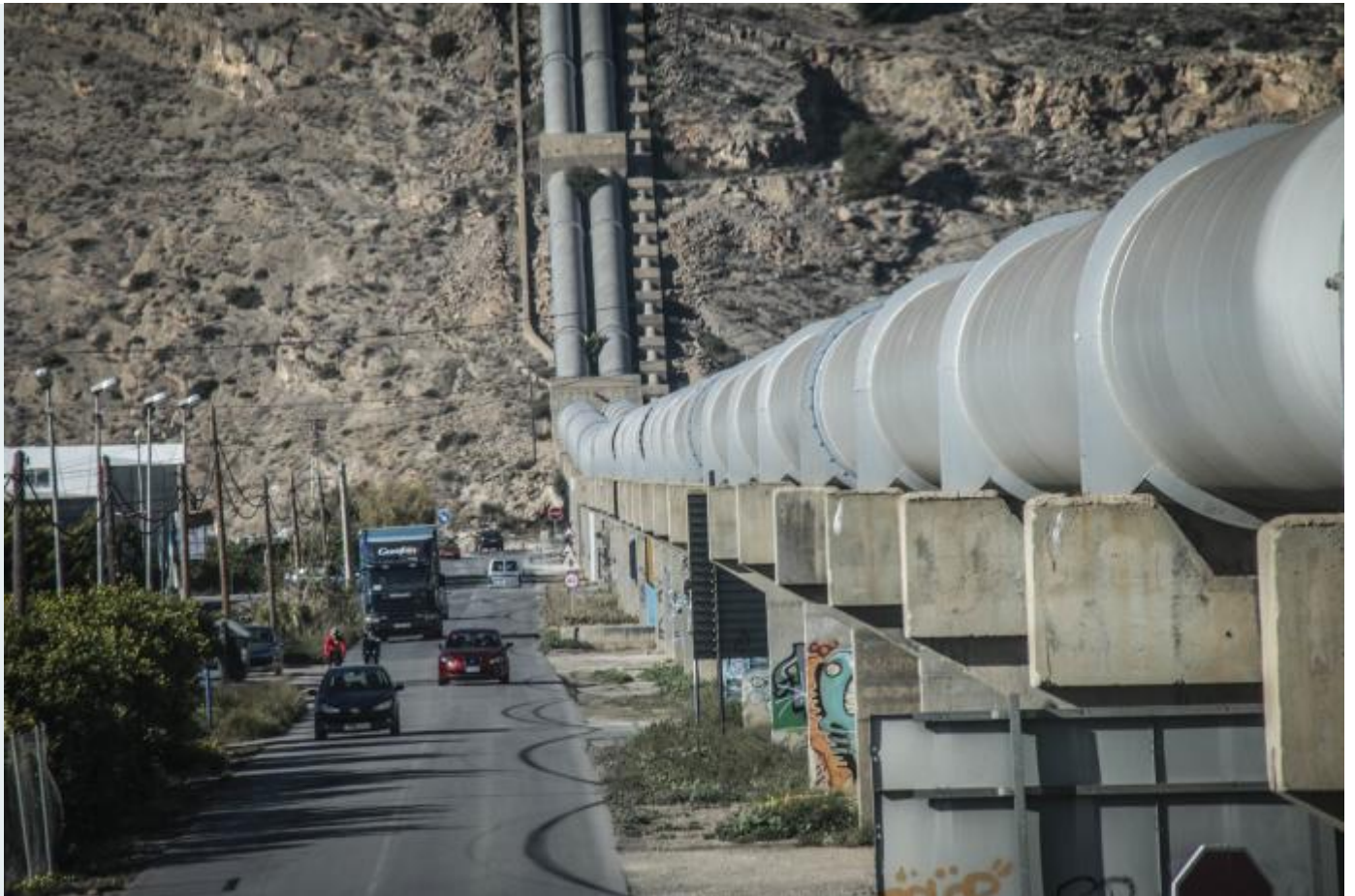
Infraestructura del trasvase Tajo-Segura, en la Vega Baja. Tony Sevilla
