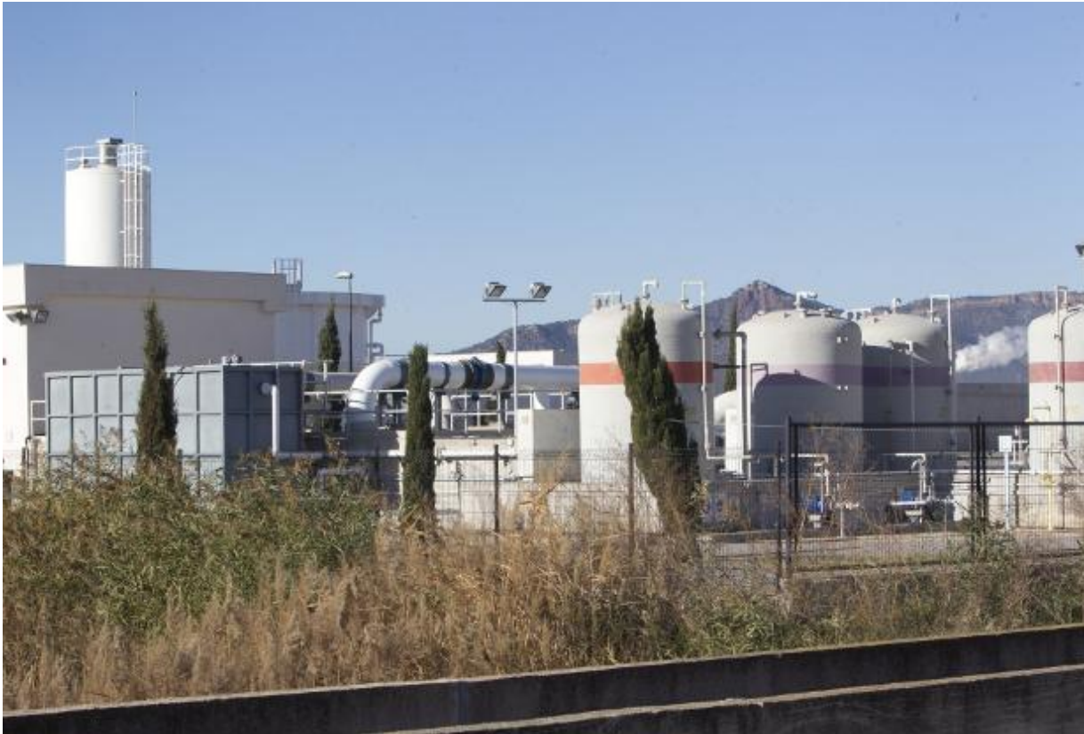
Desalinizadora de Sagunto. damián torres
