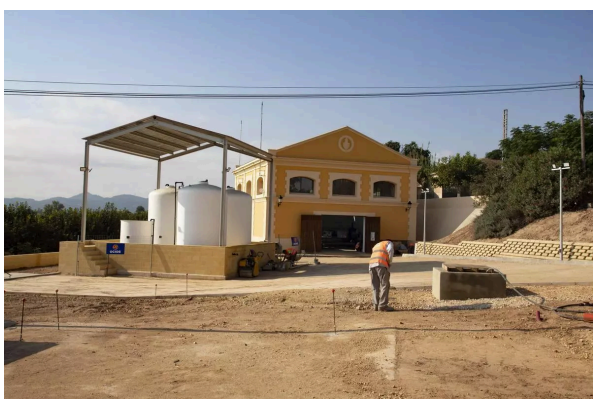
AlObras de modernización del regadío de los sectores 3 y 5 de la Acequia Reial Del Xúquer / AGUSTÍ PERALES IBORRA
