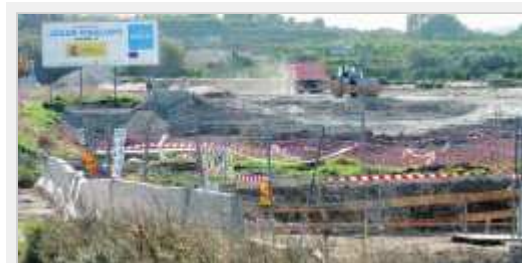
TRASVASE. Imagen de las obras de la conducción del Júcar-Vinalopó en uno de los tramos. /IRENE MARSILLA
