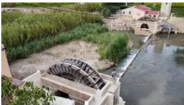
El río Segura en su entrada a la provincia de Alicante, en el azud de Las Norias de Orihuela / ÁXEL ÁLVAREZ
