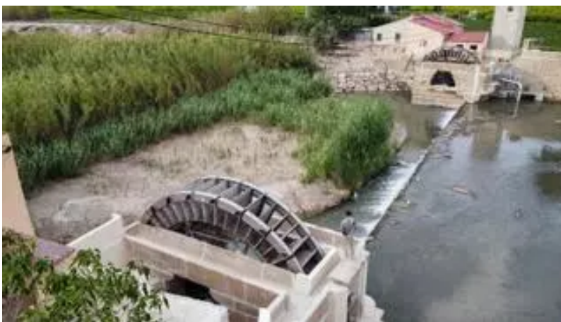
Azud de Las Norias, donde se derivan los caudales del Segura a algunas de las principales acequias de la Vega Baja / ÁXEL ÁLVAREZ
