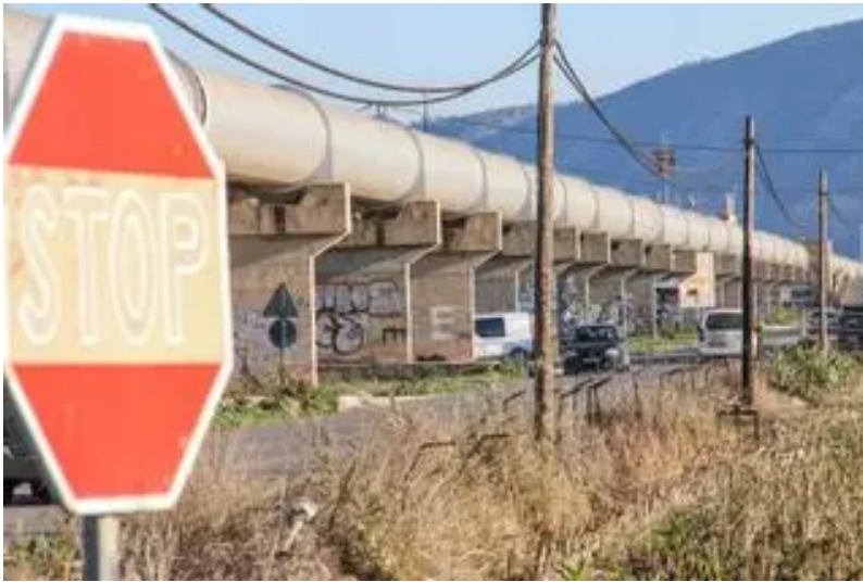
Tubos trasvase Tajo-Segura a su paso por el Sifón de Orihuela / TONY SEVILLA
