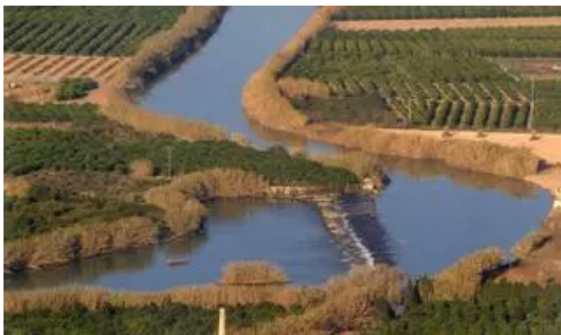
Punto de captación de los caudales del Júcar que se trasvasan a la provincia de Alicante en el tramo final del río del azud de la Marquesa en Cullera (València) / CHJ
