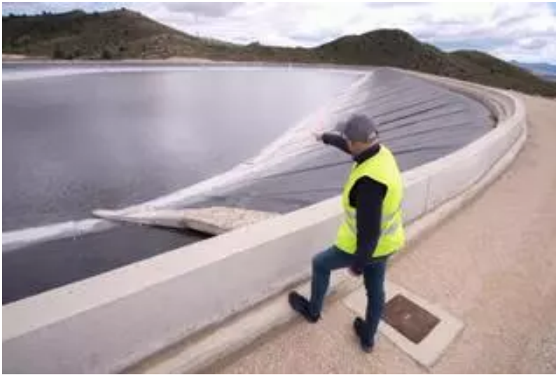
Embalse de La Cuesta en Villena, que forma parte de la infraestructura del postravase Júcar- Vinalopó / ALEX DOMÍNGUEZ
