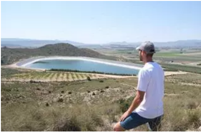
Embalse de La Cuesta. Una de las infraestructuras de regulación de los caudales del Júcar en el postravase / ÁXEL ÁLVAREZ
