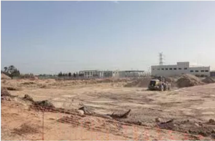
Las obras se llevan a cabo junto a la desaladora / HÉCTOR FUENTES
