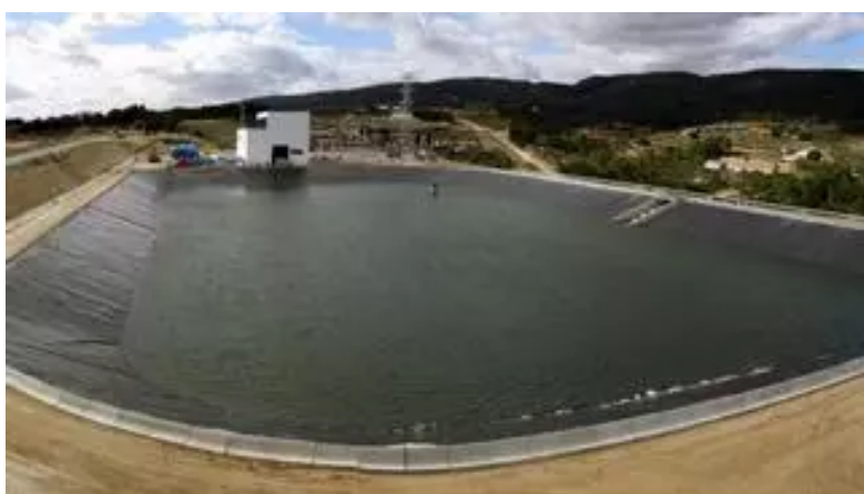
La balsa de regulación de caudales del trasvase Júcar-Vinalopó ubicada en Moixent. /
